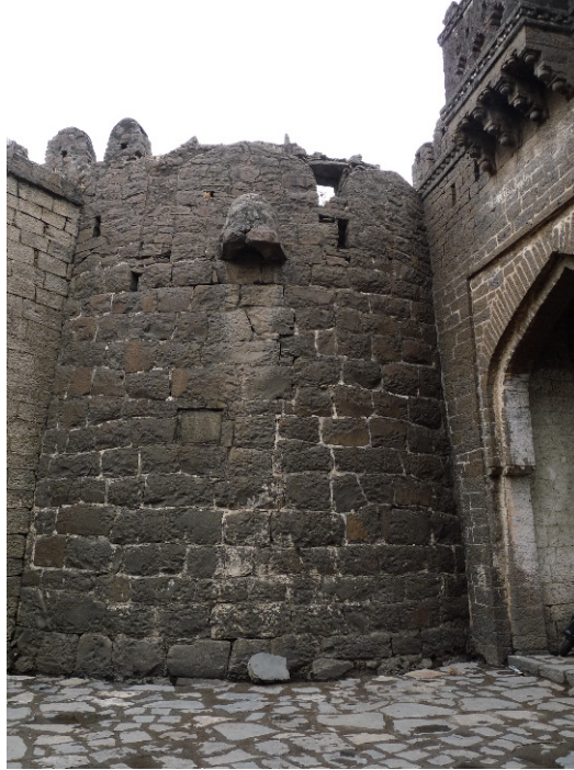
Figure 28 : bretèche capuchon du fort de Gulbarga aménagé dans un merlon, 16ème siècle
