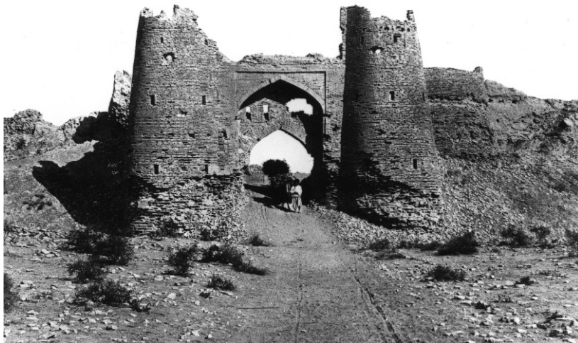
Figure 43 : porte d'Abd Khan Kala, Merv, V. Zhukovsky. Les similitudes architecturales et du plan urbain de l'Abdullah Khan Kala à Merv, construit à la même période que Firozâbâd, sont notables
