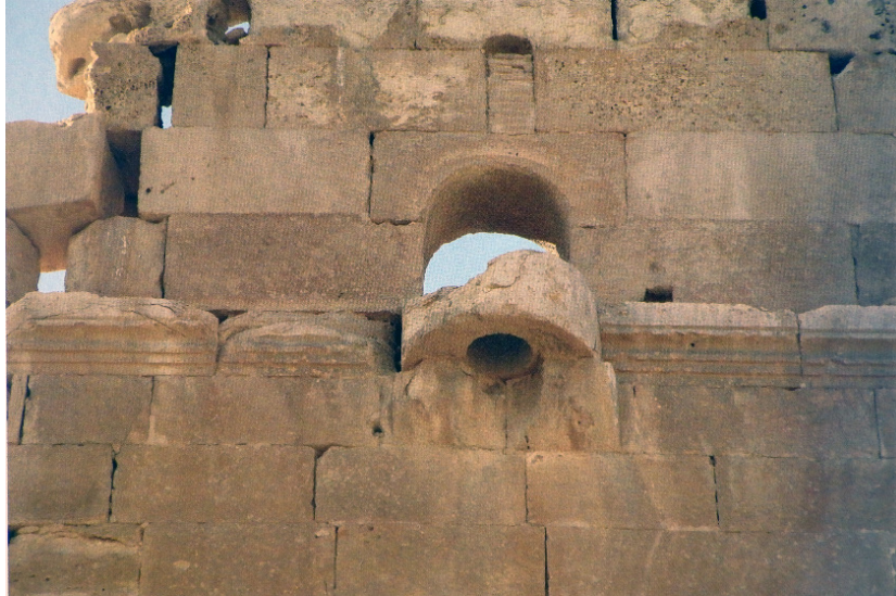
Figure 26 : bretèche de la tour Ghassanide du fort de Qasr al-Hayr al-Garbi surmontant une porte, 727 101
