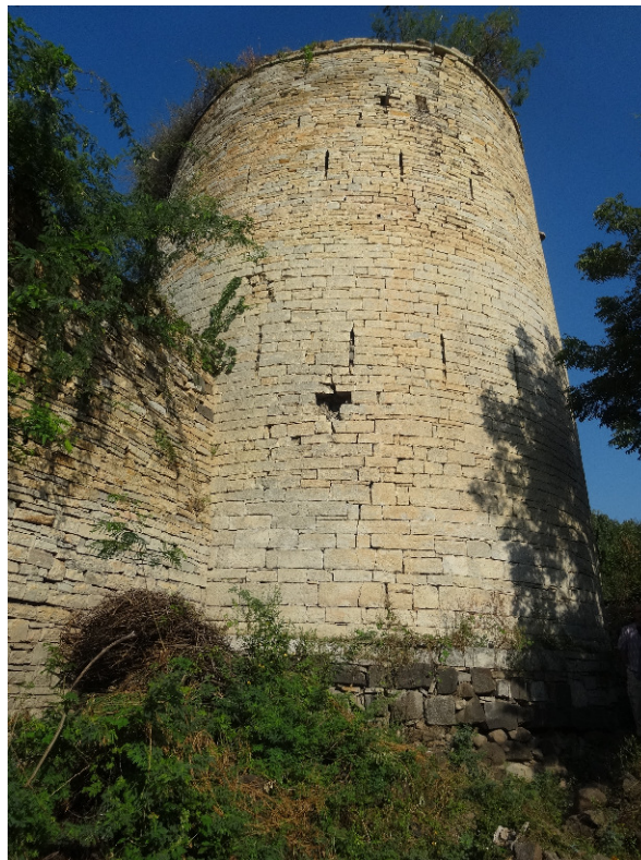
Figure 114 : tour sud-est du fort
