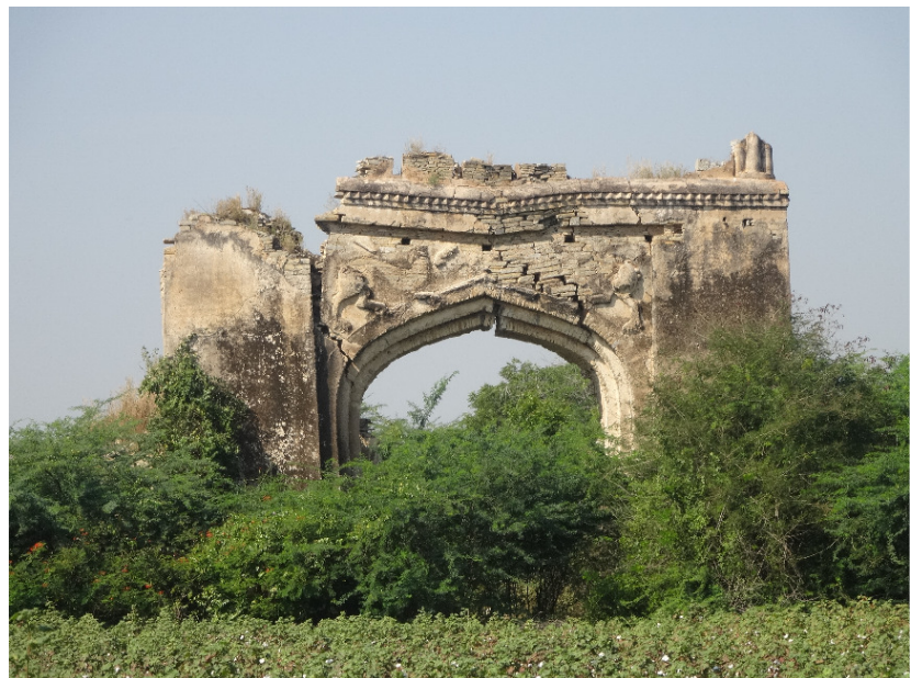
Figure 66 : porte monumentale de l'entrée de la zone palatiale de Firozâbâd
