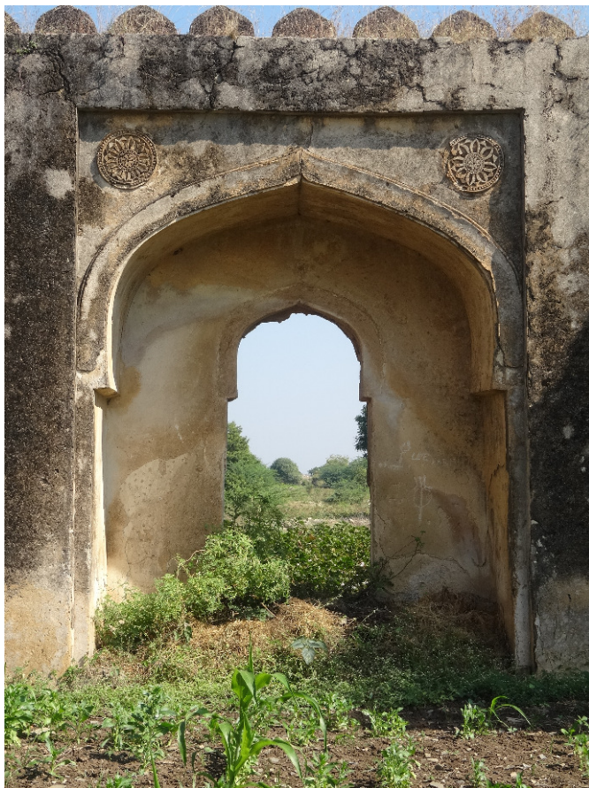
Figure 96 : baie latérale de la mosquée de Firozâbâd
