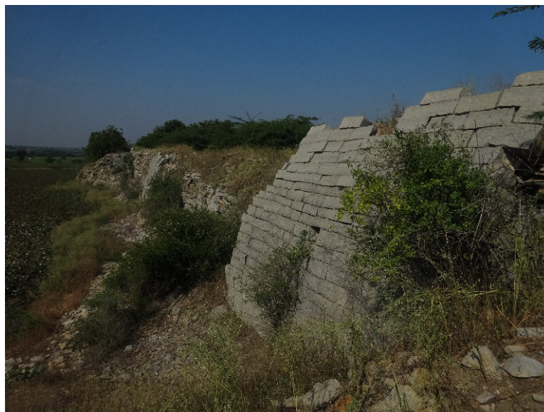
Figure 23 : vue de l'enceinte est, Firozâbâd
