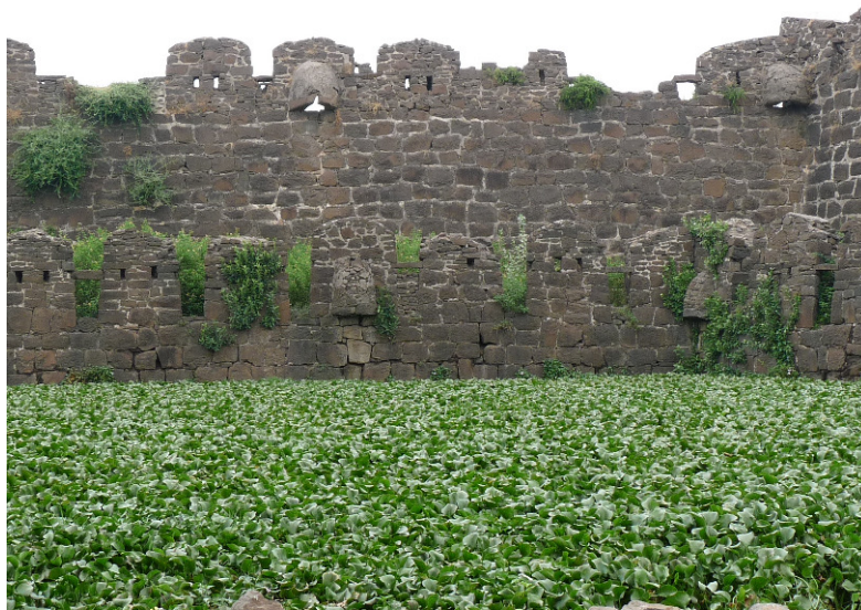
Figure 29 : deux séries de bretèche capuchon du fort de Gulbarga aménagé dans un merlon, 16ème siècle
