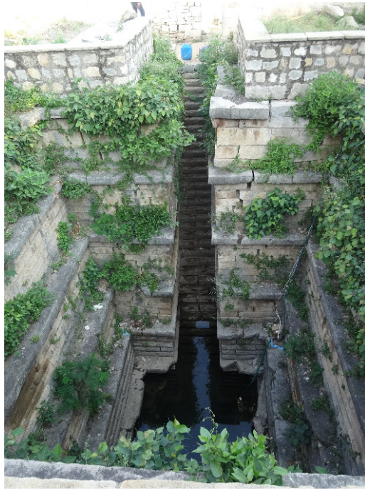
Figure 111 : bâoli du temple à l'extérieur du fort
