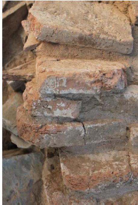
**Fig. 9.** Disgregación de algunos ladrillos del arco derrumbado sobre el patio (UEC2263 y UEC2267). También pueden verse numerosas grietas y fisuras, concreciones carbonatadas y eflorescencias salinas de color blanco.
