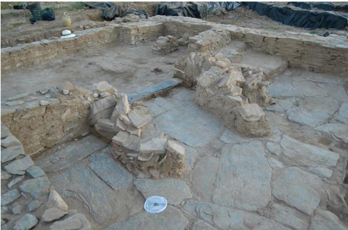
**Fig. 11.** Aspecto del arco de ladrillo derrumbado sobre el patio, tras retirar las protecciones temporales de la campaña anterior. Puede verse que los refuerzos de mortero de cal y arena pigmentado, han sido efectivos para evitar nuevos desplomes.
