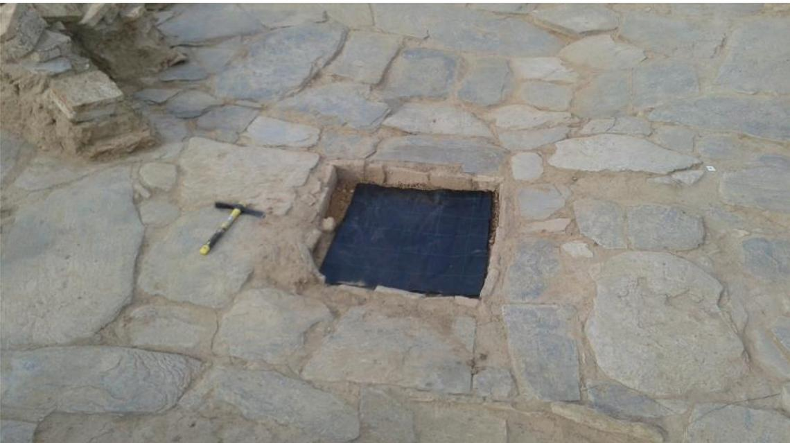
**Fig. 37.** Colocación del geotextil en la boca del aljibe F2993.
