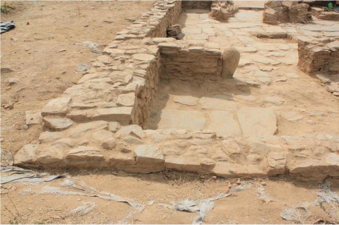
**Fig. 23.** Aspecto de los muros recrecidos tras secar los morteros de tierra. Puede verse que el relleno de mampostería del interior del muro, queda más elevado que las piedras exteriores, para favorecer el drenaje y evitar embolsamientos de agua.
