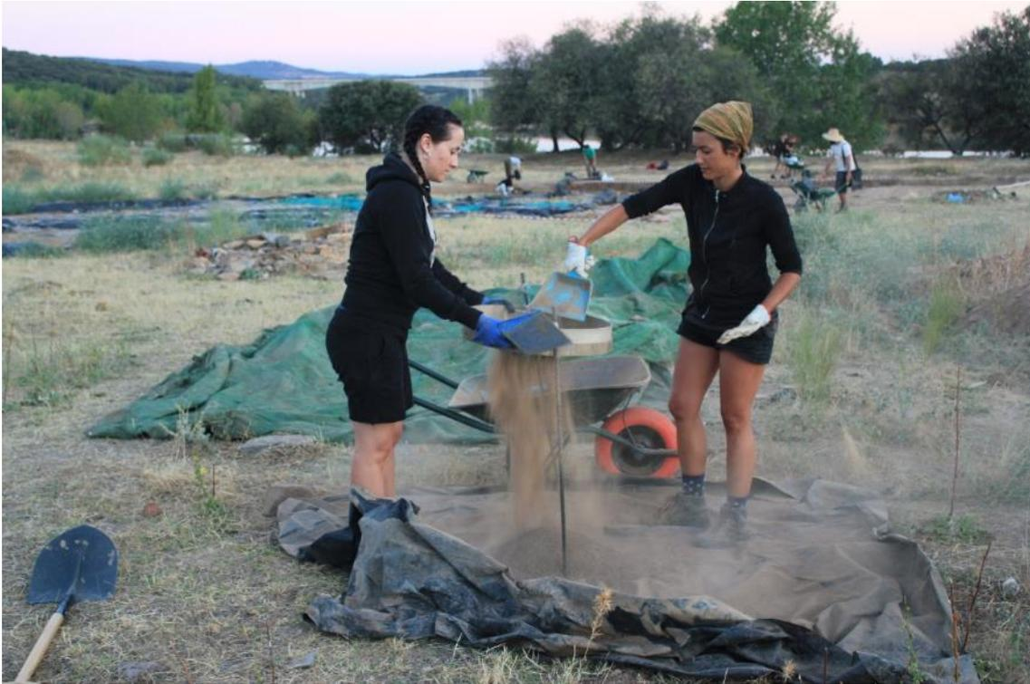
**Fig. 15.** Cribado de la tierra de la propia excavación, para la preparación del mortero.
