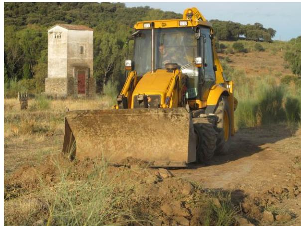
**Fig. 1.** Retira del nivel superficial con medios mecánicos.
