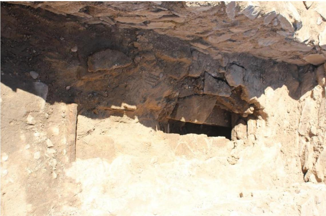
**Fig. 8.** Canalización de la Estancia L, donde se han desprendido algunos ladrillos que en origen se encontraban adheridos con morteros de cal y arena.
