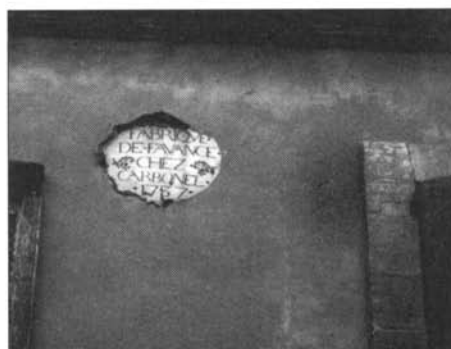
Figure 8 : Enseigne en faïence peinte en bleu conservée sur la façade de l'atelier de Carbonel.
