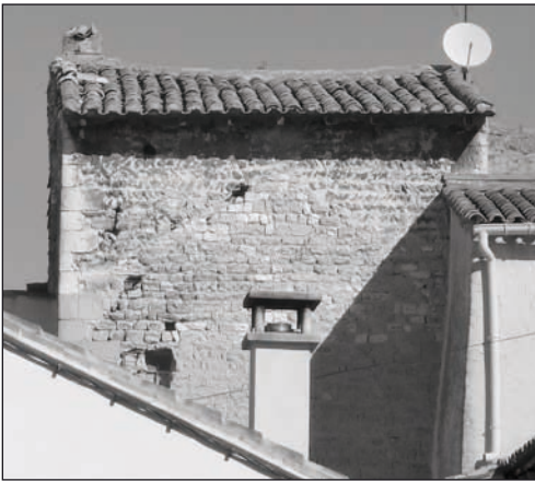
Fig. 13 : Partie supérieure d'une tour du Thor avec son pignon d'origine surélevé d'un étage crénelé. (Cliché N. Duverger, Direction du Patrimoine de L'Isle-sur-la-Sorgue, 2016)
