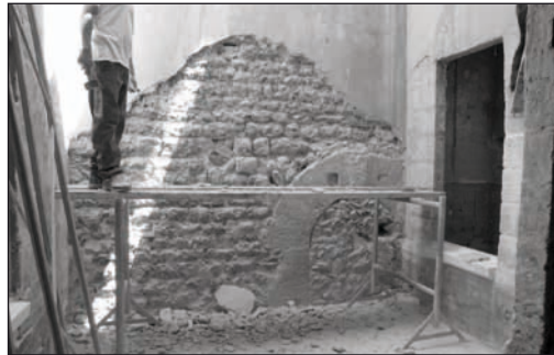
Fig. 1 : Dégagement de l'élévation d'une tour romane lors d'un ravalement de façade, place du Change à Avignon (Cliché F. Guyonnet, Service d'Archéologie du Département de Vaucluse, 2006)
