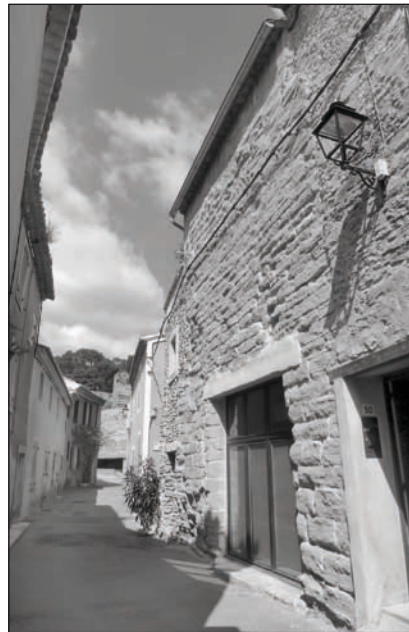
Fig. 6: Tour médiévale écrêtée et transformée en simple maison à Saumane (Cliché F. Guyonnet, Direction du Patrimoine de L'Isle-sur-la-Sorgue, 2015)
