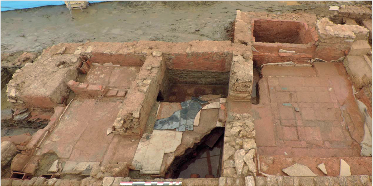
Figure 9 : Les trois pièces de bains des thermes. De gauche à droite : caldarium, tepidarium, frigidarium. (© CD 08).
