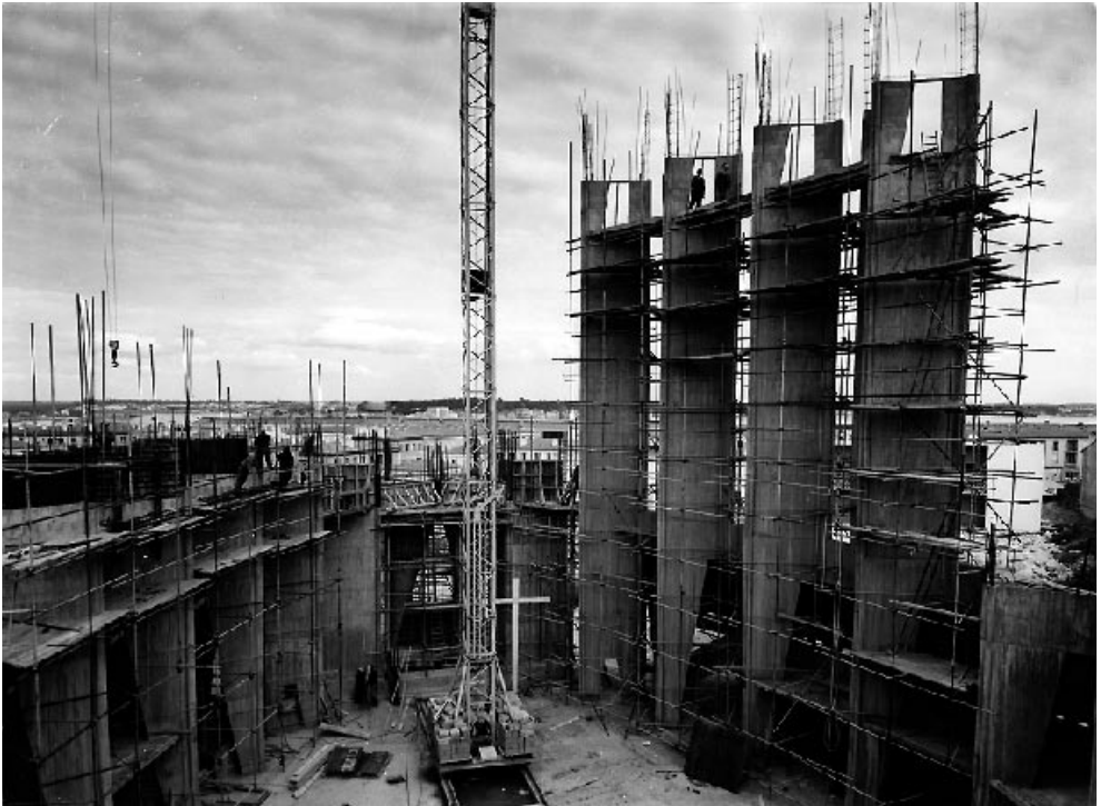
Fig. 10. - Royan, église Notre-Dame, vue du chantier (Ph. Duprat).
