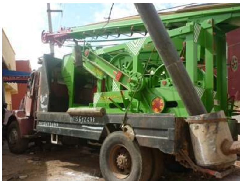
Figure 4. Une foreuse du Saïss
