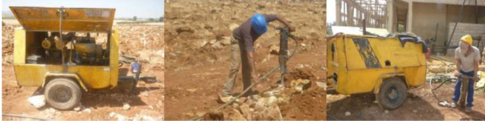
Figure 2. Le marteau-piqueur dit « compresseur » dans le Saïss, coopérative « B », 2014
