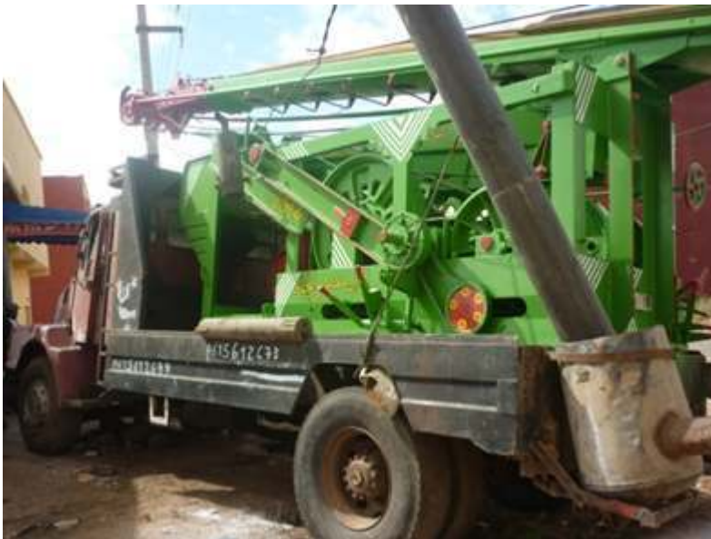
Figure 4. Une foreuse du Saïss
