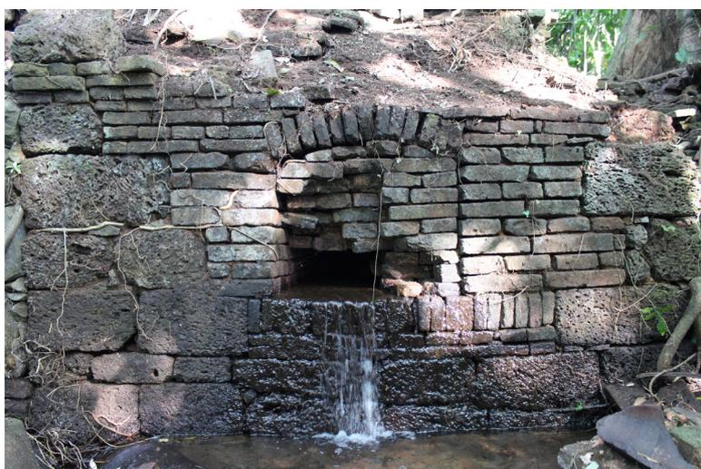
Figure 6 Fenêtre permettant l'évacuation de l'excédent de la retenue d'eau
