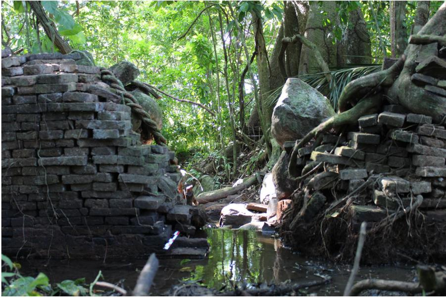
Figure 7 Zone arrachée du barrage poids
