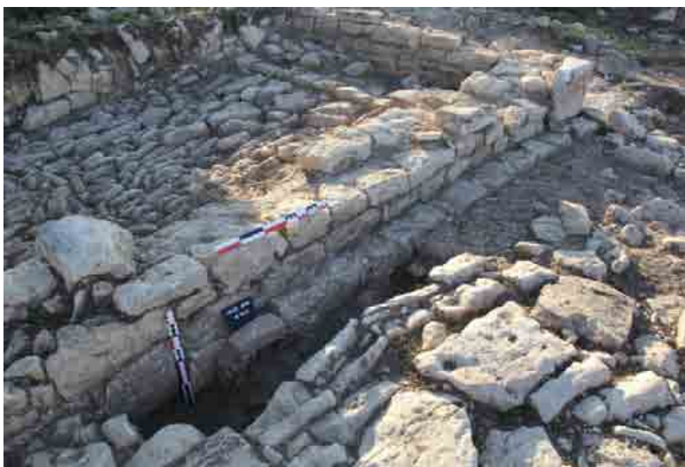
Figure 61 : Tranchée de fondation du mur 409 (salle B) dernier état (phase 5) (Cl. E. Normand)
