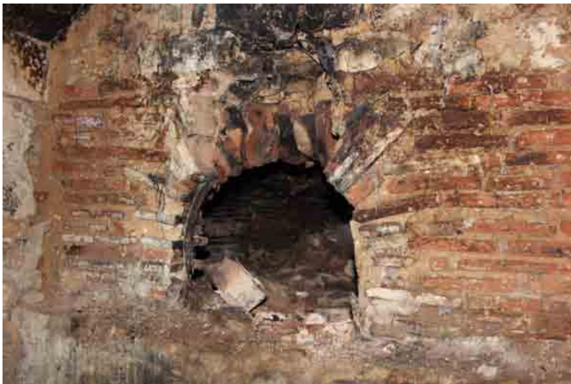
Figure 24 : Détail du four présent dans l'habitat principal de la cabane de l'Île Marteau
