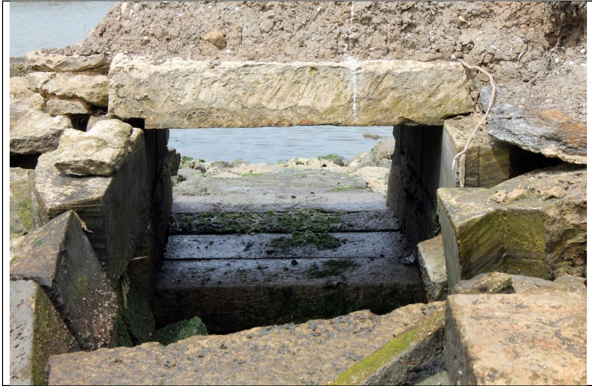
Fig. 9 : l'ouverture ouest depuis le conduit éventré est. On remarque la taille soignée des blocs (B. Gissinger).
