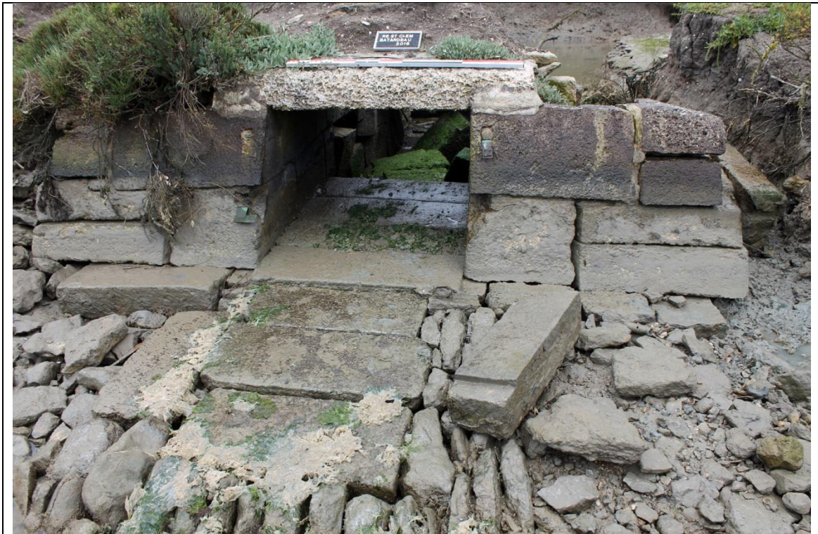
Fig. 8 : l'ouverture côté marais, ouest, et la rampe d'accès (B. Gissinger).
