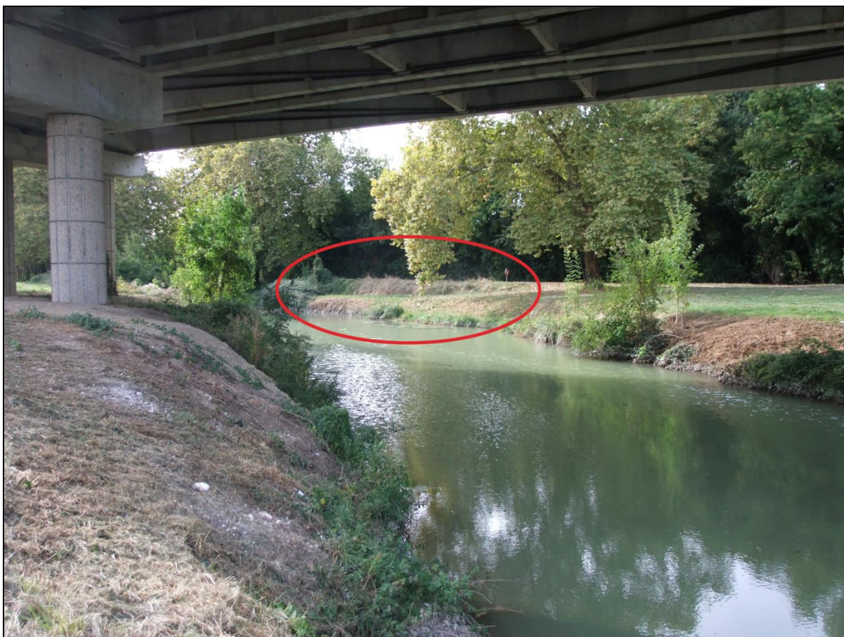
Figure 11 : Elargissement des Caffaudières.
