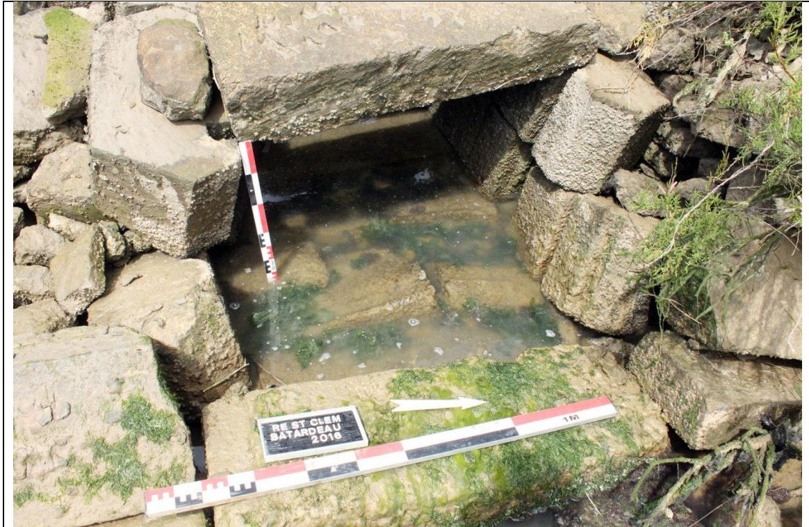
Fig. 10 : conduit partiellement effondré. A noter les rainures sur les parois latérales permettant de glisser des planches pour réduire le débit (B. Gissingner).
