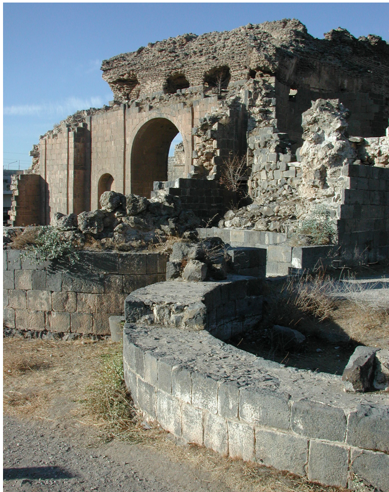
Fig. 12 – Bains de Philippopolis , les salles chaudes 7, 8 et 9, vers l'ouest.
