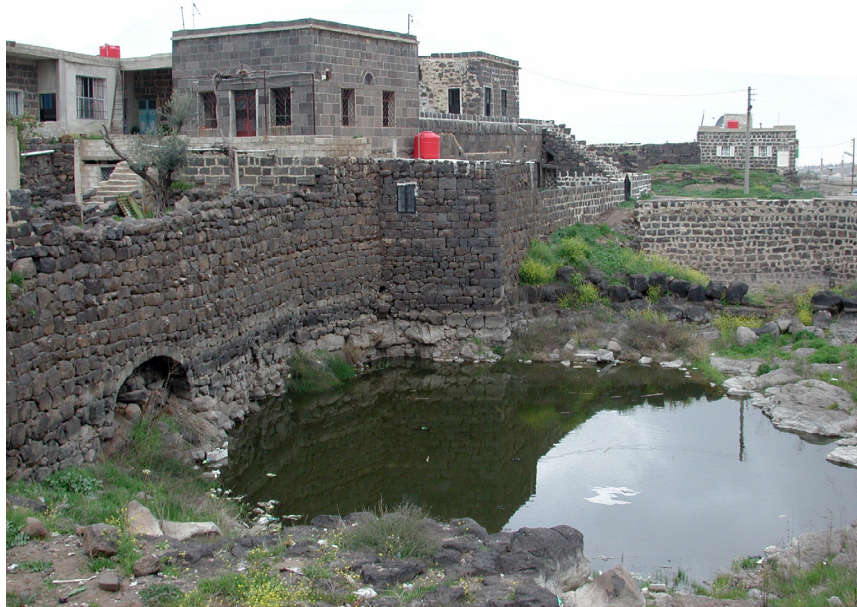
Fig. 4 - Sleim, la birket (réservoir à ciel ouvert) vue vers le nord. Au second plan, les toits terrasse des bains.
