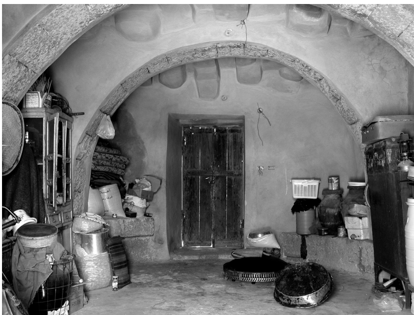
Fig. 16 - Salle chaude intermédiaire ( destrictarium/laconicum ), vue intérieure vers le nord, vestiges de l'abside percée par la porte moderne. La couverture actuelle, constituée d'arcs et de poutres, a remplacé la voûte initiale.
