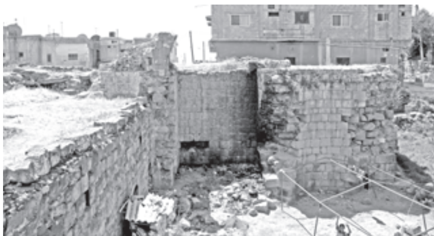
Fig. 22 - Les bains d'Adraha, vue d'ensemble vers l'ouest (Th. Fournet, 2008).
