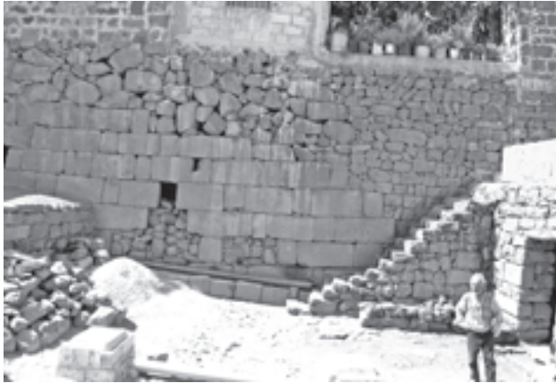
Fig. 11 - Mur à carreaux et boutisses à la base de la plateforme de la citadelle (photographie Mission Archéologique Française en Syrie du Sud).
