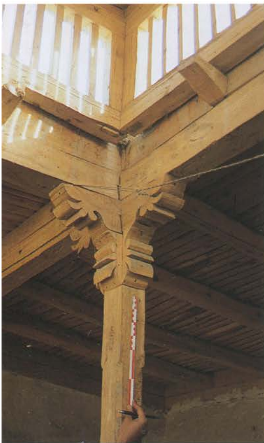
Fig. 21. Chapiteau et lanternon (détail) vus de l'intérieur de l' iwan (photo A. Cornet).
