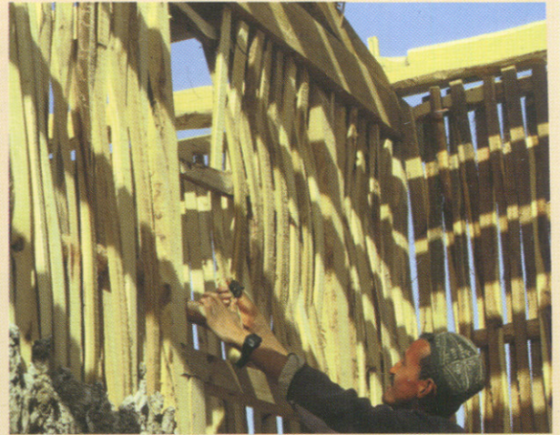
Fig. 5. Remplissage en branches et en planchettes de peuplier tressées (T. Fournet).
