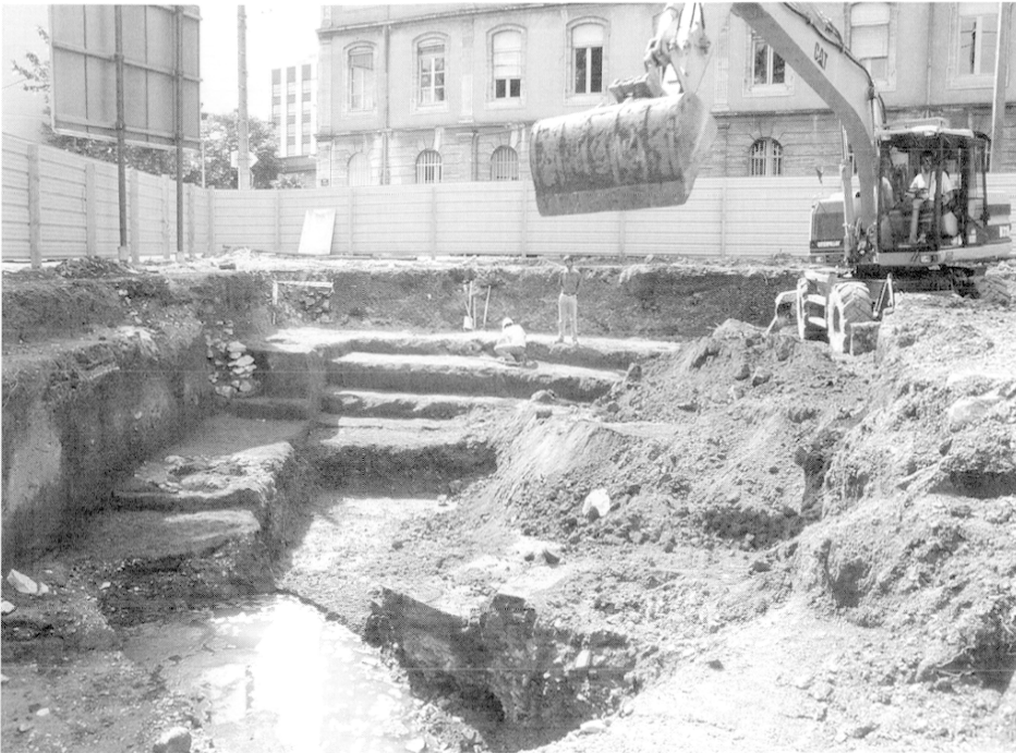
Fig. 5. Vue d'ensemble de la fouille depuis l'est (cliché O. MaufRAS, Inrap).
