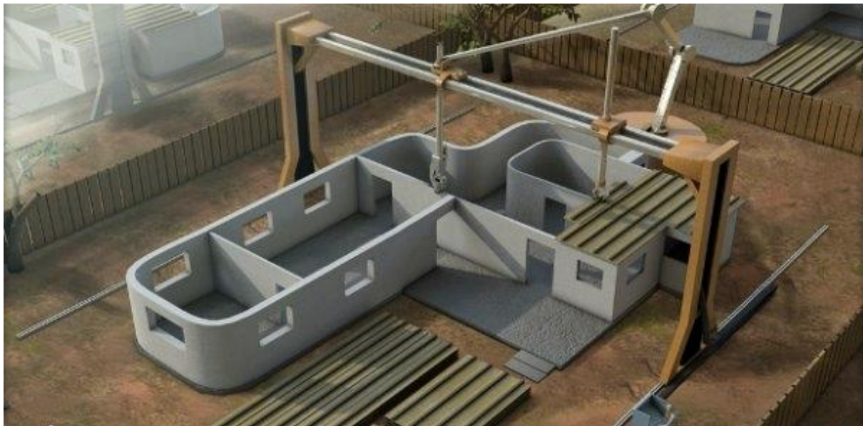
Contour Crafting, une machine capable de construire une maison de 225 mètres carrés en 24h
