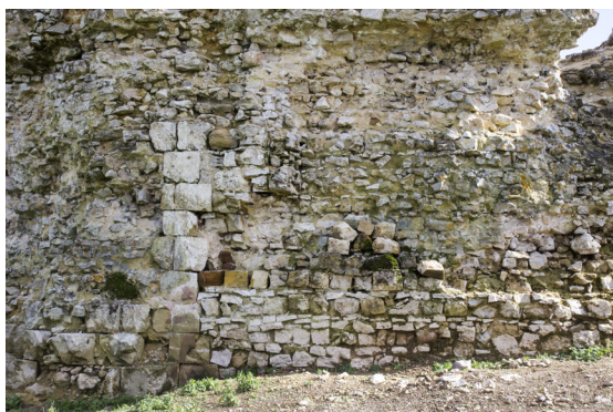
Figure n° 14 – Contrefort et parement de la tour – cliché H. Meunier
