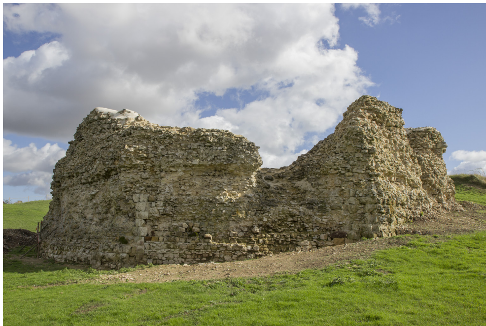
Figure n° 13 – La tour maîtresse 1004, vue de l'ouest – cliché H. Meunier
