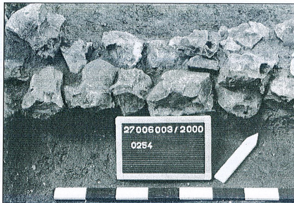
Fig. 13 - Détail d'un solin du bâtiment 2 -
