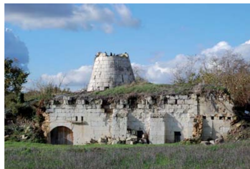
Figure 16 : Le moulin Garreau avant le commencement des travaux de restauration
