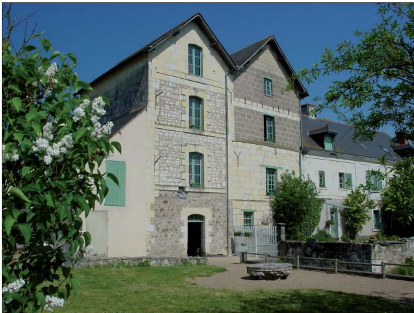
Le moulin de Sarré : à gauche, l'entrée de l'ancien moulin
