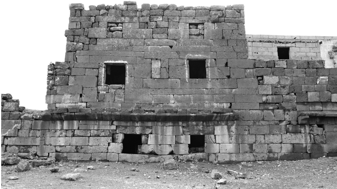
Figure 10. Bosra. Façade ouest sur rue de la maison 2 © P. Piraud-Fournet, 2010.
