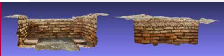
Fig. 10 - Sezione e prospetto del silos.
