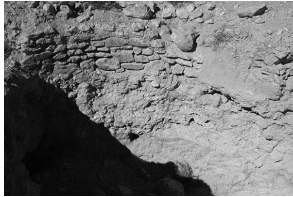
Figure 10 – Henchir El-Kamour, l'abside de l'église. [M. Hermassi]
