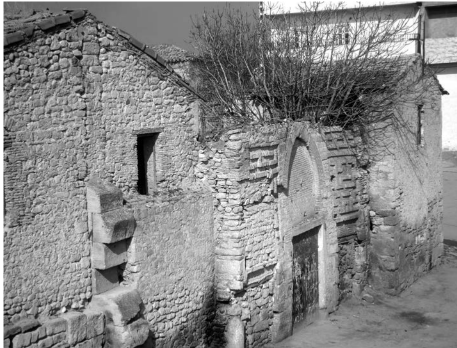
Figure 7 – Façade est, le mur antique 1 apparaît sur une hauteur de 3,20 m. [Y. Aibeche]
