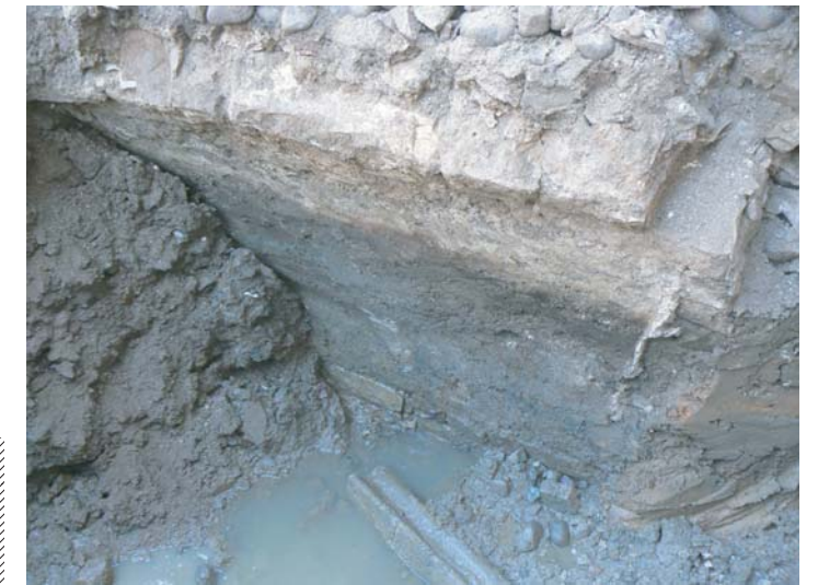
fig.5 : vue du mur I.241 et de la voûte I.242 depuis le sud-ouest
