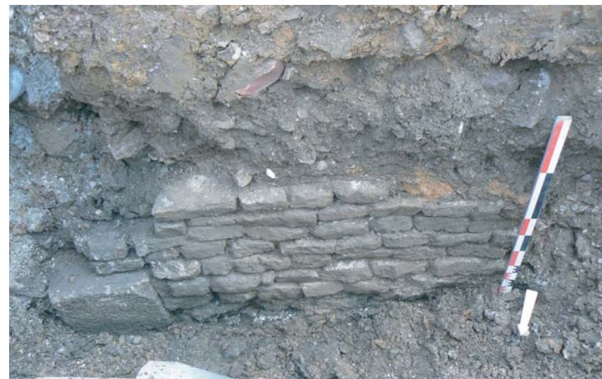
fig.3 : vue du MUR I.262 depuis le nord
