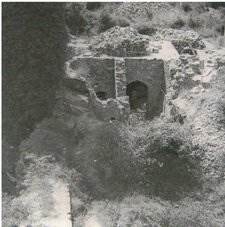
CR_009 : état avant dégagement
