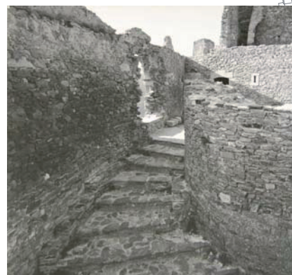
CR_021 : état après restauration, depuis le sud
