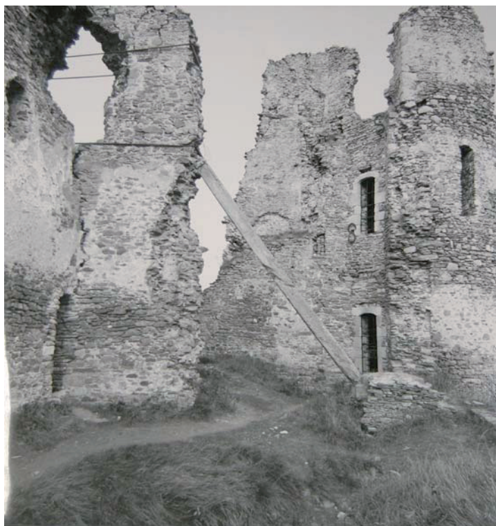
CR_041 : mur nord avant restauration
