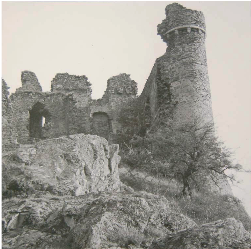
CR_015 : état avant restauration
