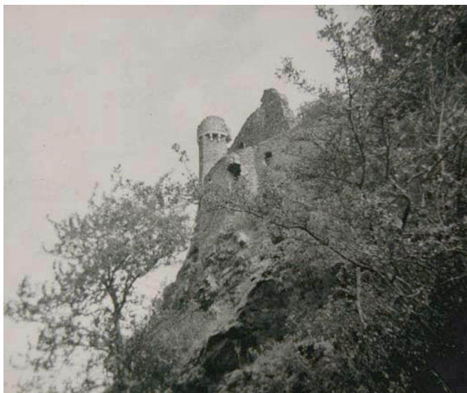
CR_072 : façade ouest
