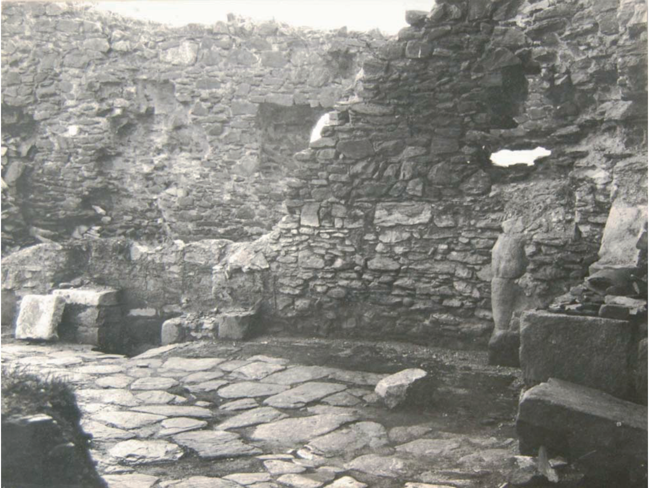
CR_058 : état avant restauration, depuis le nord-est
