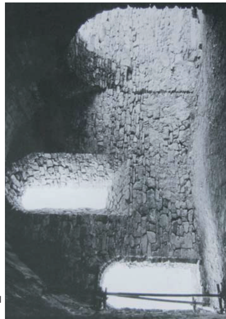
CR_003 : état en cours de restauration
