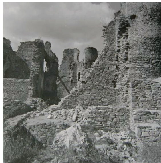
CR_035 : mur nord après restauration
