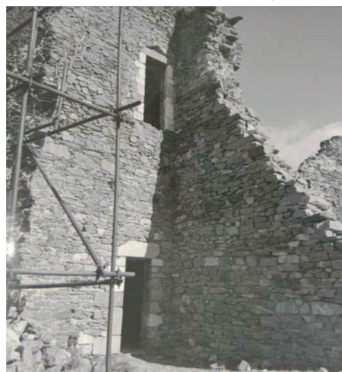
CR_042 : id. en cours de restauration
