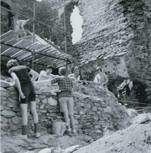
CR_033 : état en cours de restauration, depuis le nord
