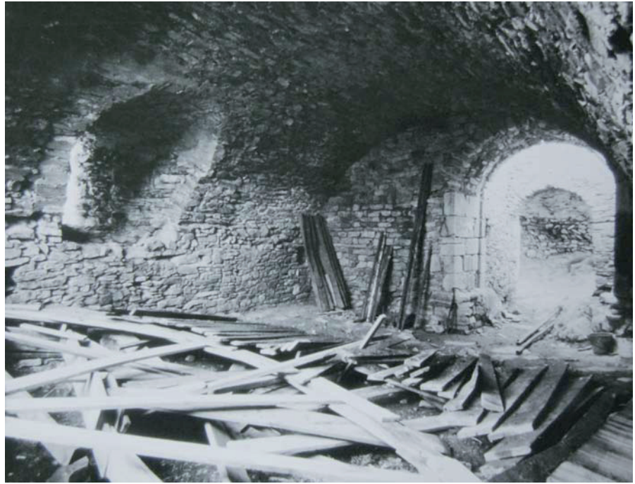
CR_013 : état en cours de restauration
