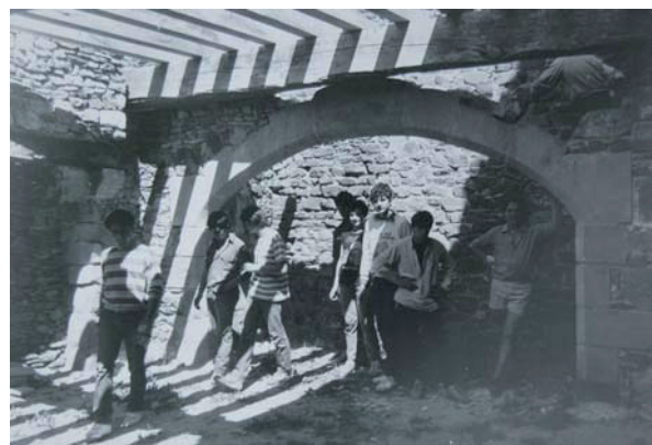
CR_030 : état après restauration
