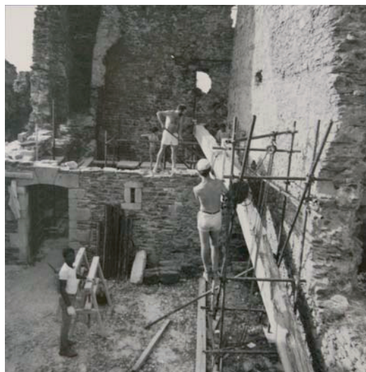
CR_025 : état en cours de restauration depuis le sud
