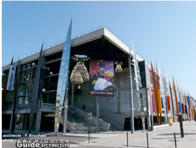
Centre commercial Beaulieu à Nantes - restructuration Crédit : www.archiguide.fr
