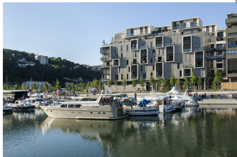
Vue des loges depuis la darse. Concepteur(s) : Dusapin - Leclercq (photographie réalisée dans le cadre de la mission architectures nouvelles et patrimoine bâti 2011-2012) © Aurélie Leplatre, et SPLA Lyon Confluence.
