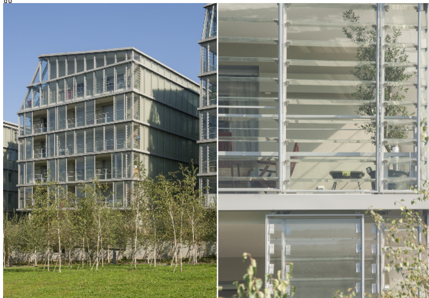
Double peau habitée. Conceptrice : Tania Concko (photographies réalisées dans le cadre de la mission architectures nouvelles et patrimoine bâti 2011-2012) © pour les deux images Aurélie Leplatre, et SPLA Lyon Confluence
