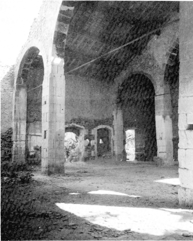
Fig. 8 - Détail des arcs et d'une partie de la charpente (document inventaire ; cliché ROUCAUTE-HELLER).
