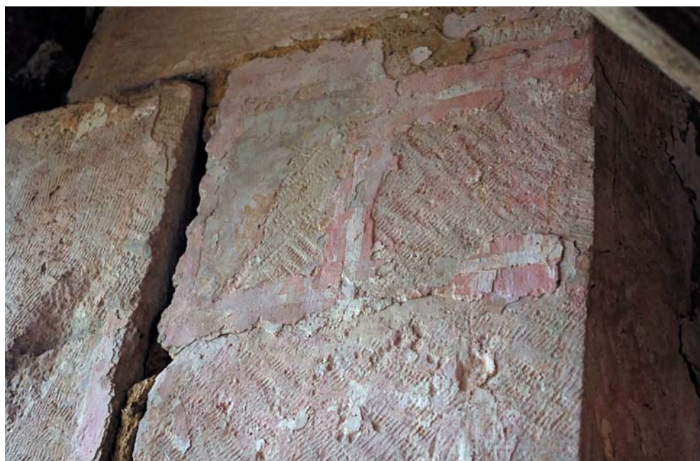
Fig. 10 - Faux joints blancs sur fond rose conservés dans l'ébrasement de la baie 409. Cliché C. Roms, INRAP.
