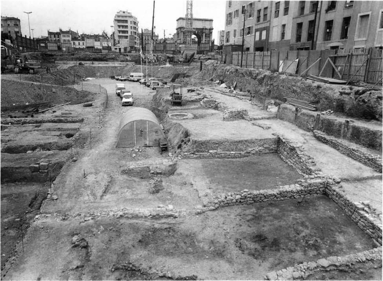
Vue générale du chantier au début des travaux.
