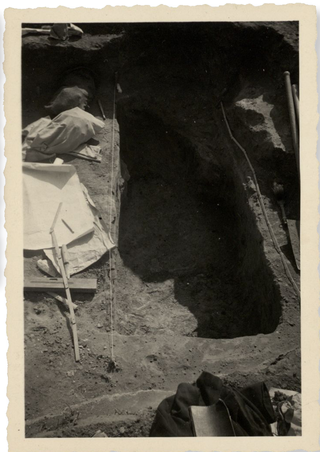
Figure 7 Fouille à Ittenheim, 1930 (cliché DRAC Alsace)
