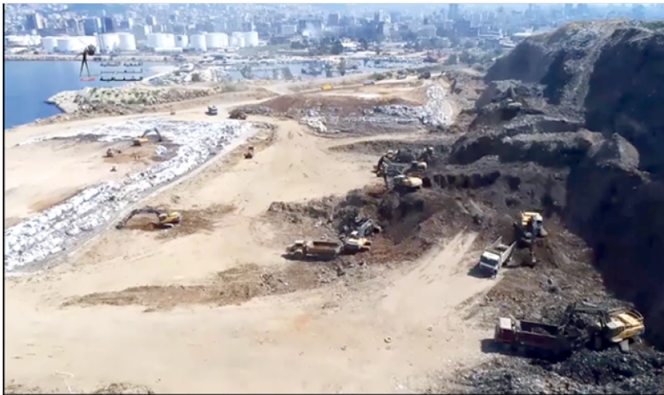
[Figure 8: Une photo des travaux en cours à Borj Hammoud (capture d'écran d'une vidéo de la Lebanese Transparency Association via L'Orient/Le Jour)]
