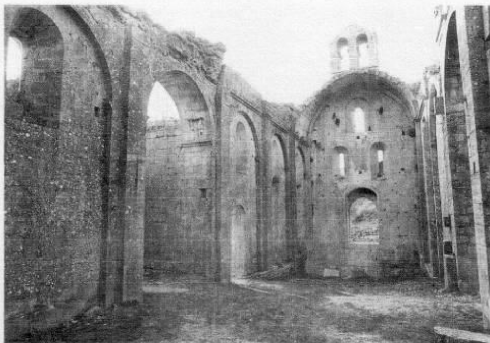
FIG. 6. — INTÉRIEUR DE LA NEF, VERS L'OUEST
