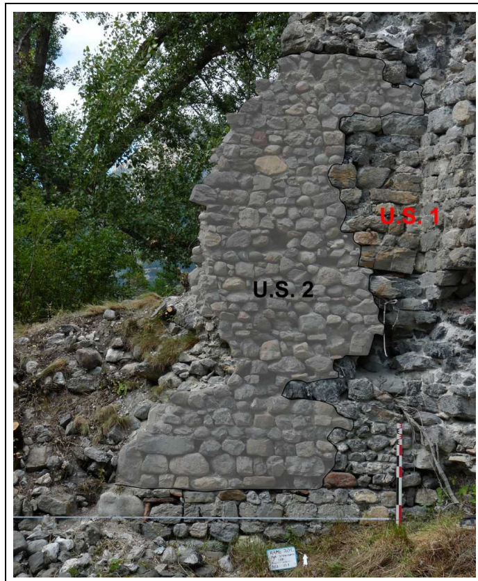
Figure 14: Détail du parement externe du mur MR2 (Réalisation B. Oury - 2012)
