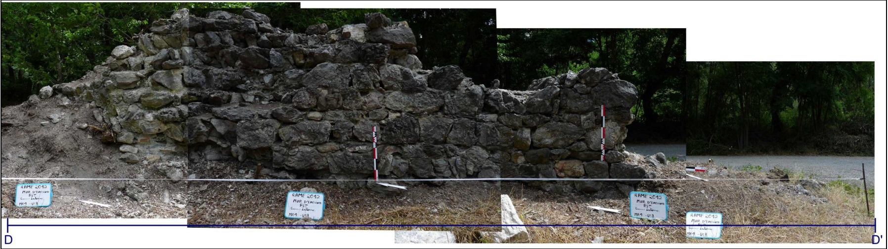
Figure 10: Relevé DD' du parement interne du mur MR1 (Réalisation C. Desmaris et B. Oury - 2012)
