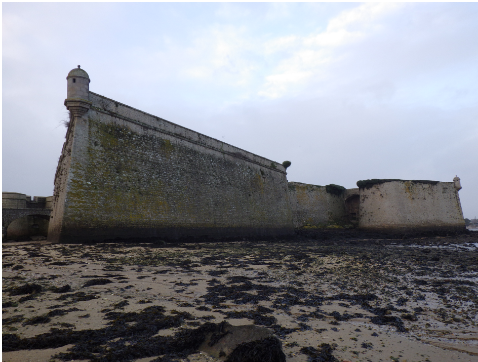
Le parapet d'origine est conservé avec son cordon sur le bastion Desmourier alors que celui de la Brèche a été abaissé et adapté à une artillerie moderne.
