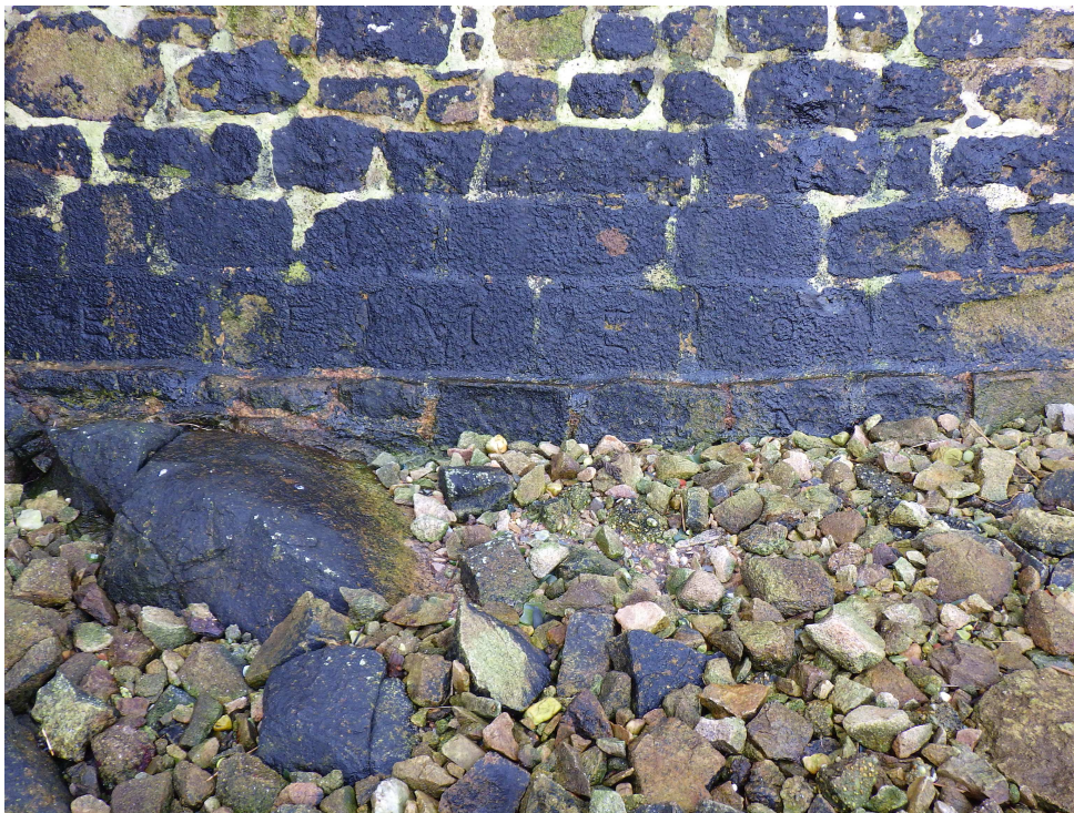
Marques de tâcheron au pied de la courtine Nord-Est.
