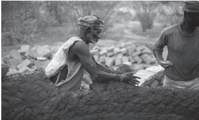
Figure D Clôre une assise. Les maçons de face : stratégie pour ne pas croiser ses mains de part et d'autre du mur.
