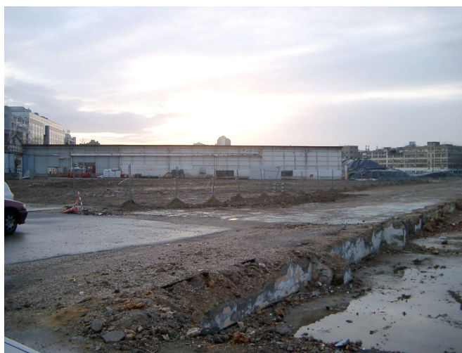
Figure 2 – Photographie de la démolition et dépollution du site de Renault-Billancourt (avril 2004). Source : Cliché A.-P. Michel.
