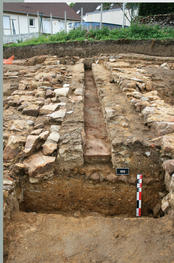
Fig. 5 Caniveau interne traversant l'ensemble 1, vue prise en direction du sud-est (cl. Inrap).
