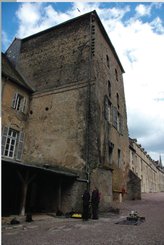
Fig. 2 Vue vers le sud du talon méridional de la porte de Saint-Andoche avec acquisition géophysique en cours (cl. S. Balcon-Berry, avril 2015).
