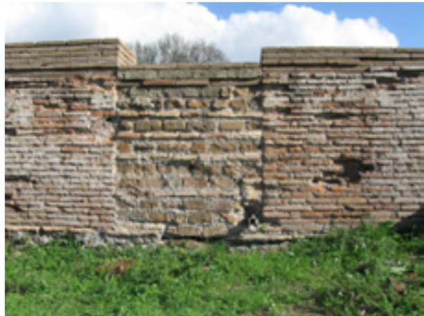
Fig. 7 - Tamponatura in opus vittatum , parete est, amb. A (USM 12). Si noti in basso a sinistra il frammento di fistula plumbea . Foto M. Turci.
