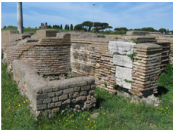
Fig. 9 - Vano di alloggiamento della caldaia. Foto M. Turci.
