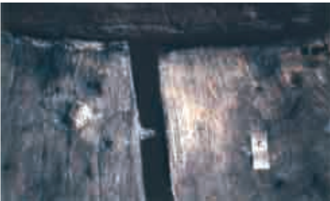
Fig. 11. Prélèvement : clouage tangential (photo É. Rieth).
