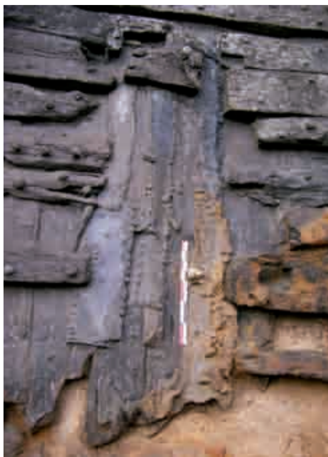
Fig. 8. Palâtrage en plomb (photo M. Guyon/INRAP).
