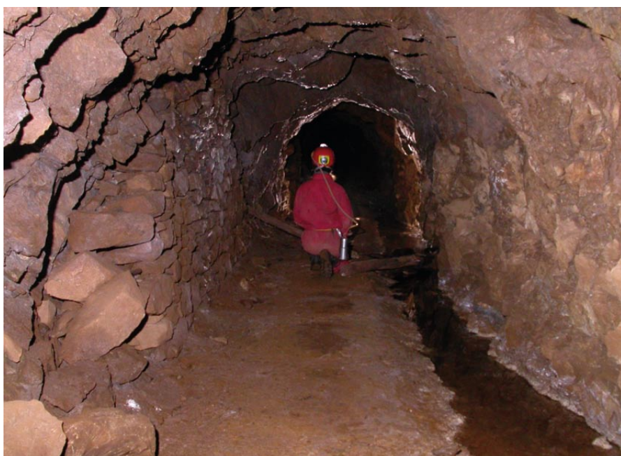
Fig. 18 : Galerie de circulation (travers-banc) du XVIII e siècle de la mine de fer de Baburet (commune de Louvie-Soubiron ; photo Eric Kammenthaler, Iker archéologie).
