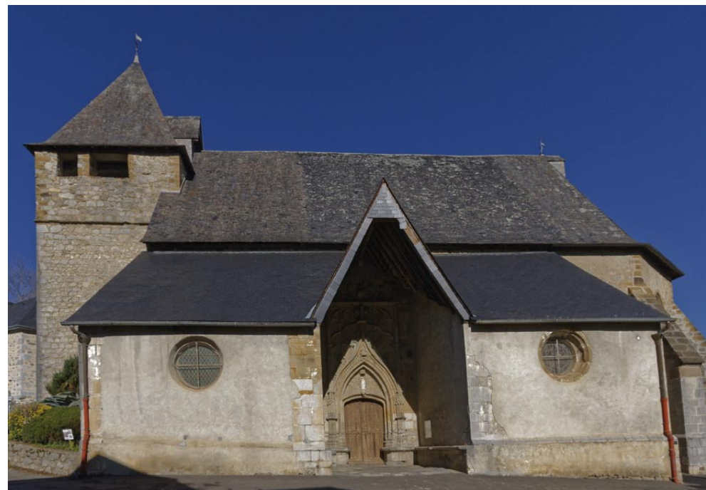
Fig. 13 : L'église Saint-Sylvestre, dans laquelle on pénètre par un magnifique portail en accolade, est un des plus beaux édifices du gothique flamboyant de la région. Sa réalisation, dans le premier tiers du XVI e siècle, renvoie à un contexte que l'on ne peut qu'imaginer faute de documents directs. Intérêt conjoint et concurrent de la besiau et du seigneur (pour différents usages et différents droits), émulation avec Arudy et Bielle (où de semblables édifices voient le jour)... (Photo Jeanne et Jean-Paul Valois).
