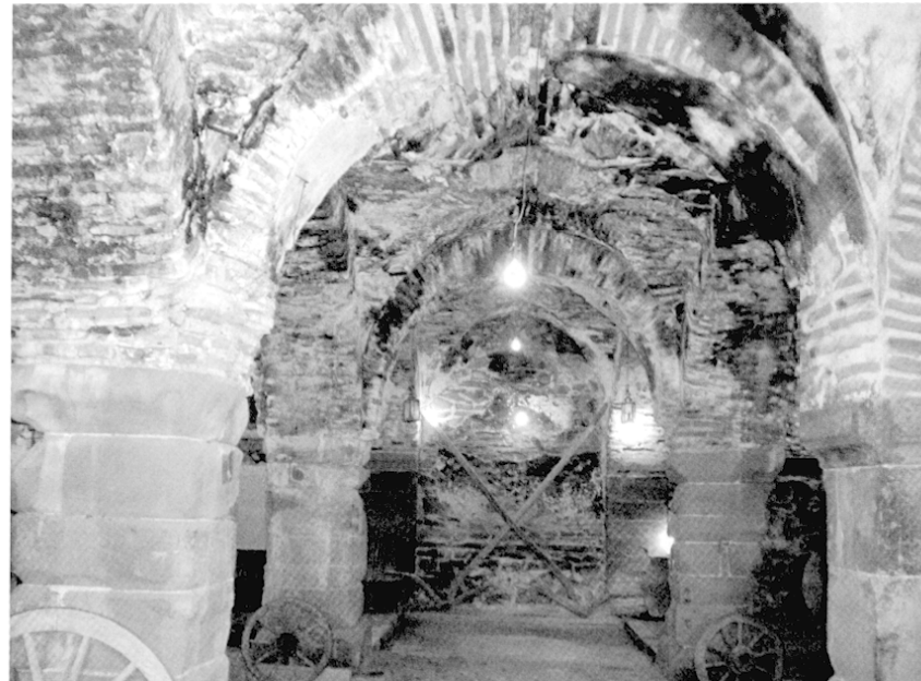
Fig. 28 : Hanönü, intérieur du caravansérail, nef centrale.
