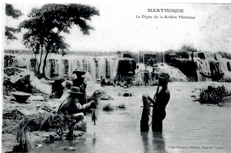
Figure 37 – Pendant qu'une femme s'occupe du linge, deux hommes pêchent du poisson en aval de la digue de la Rivière Monsieur. (Source Banque numérique du patrimoine martiniquais 2Fi2103)
