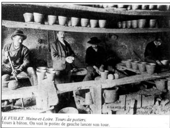
figure 90 La France de l'ouest a toujours privilégié le tour à bâton. Un atelier du Fuiet dans le Maine et Loire au début du XXe siècle
