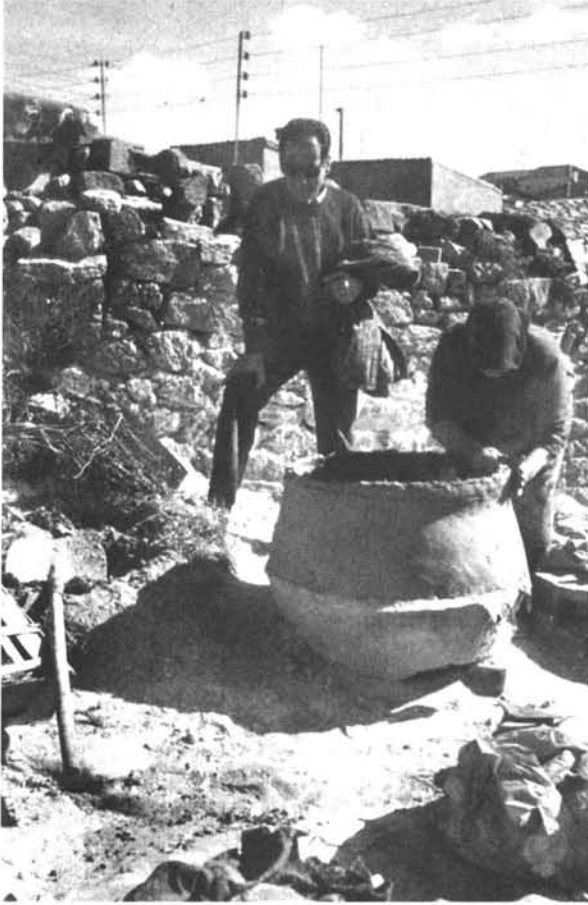
Fig. 2. Ángeles Redondo Martín modelant un four à pain sous l'œil de Miquel Bosch. En avant, la zone de préparation de l'argile au bas du tas d'argile forte (cliché M. Leenhardt).
