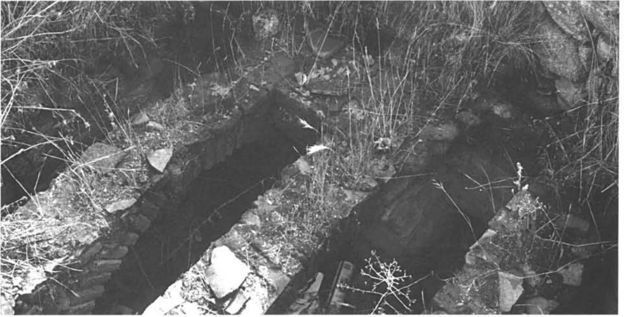
Fig. 32. Four « découvert » contemporain dont la sole est constituée de l'extrados des arcs transversaux, Carbelino de Sayago, région de Zamora (cliché J.T.)
