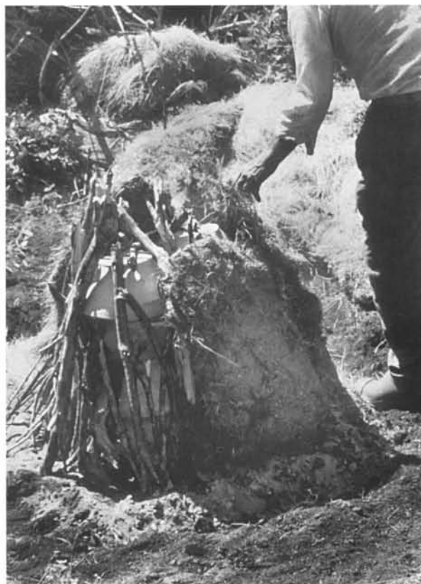
Fig. 17. Construction de la soenga à Fazamões (cliché M. Picon).
