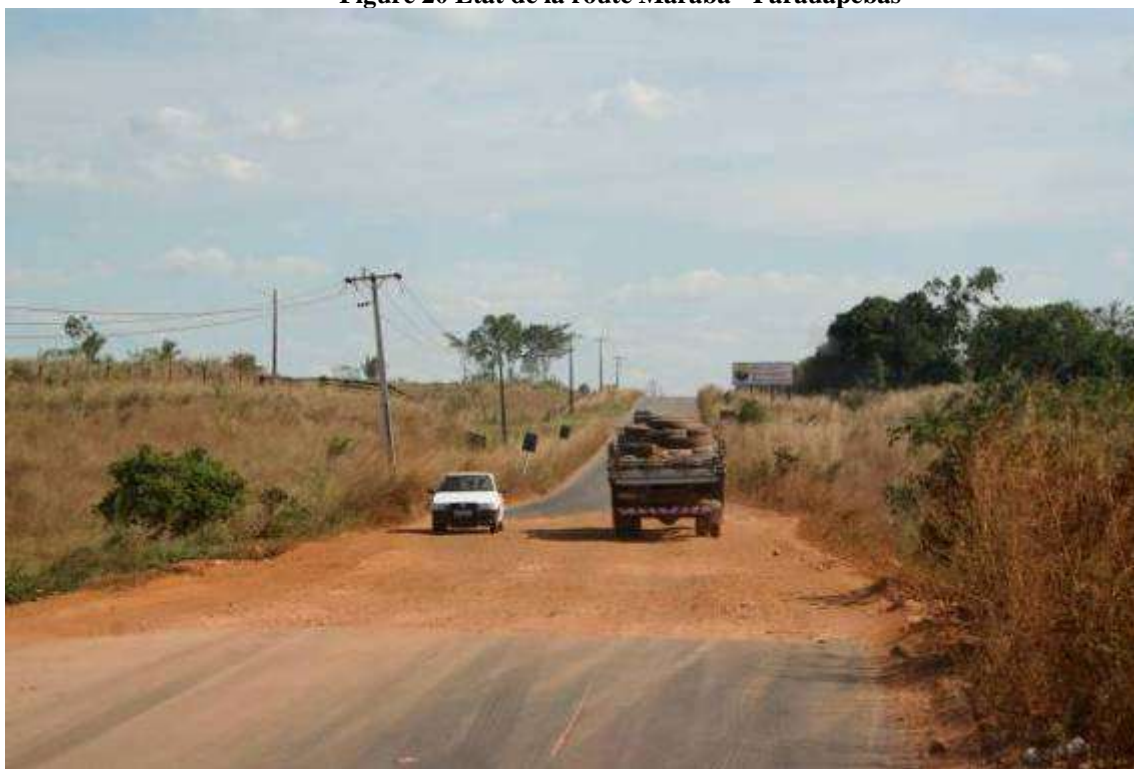
Figure 20 État de la route Marabá - Parauapebas
