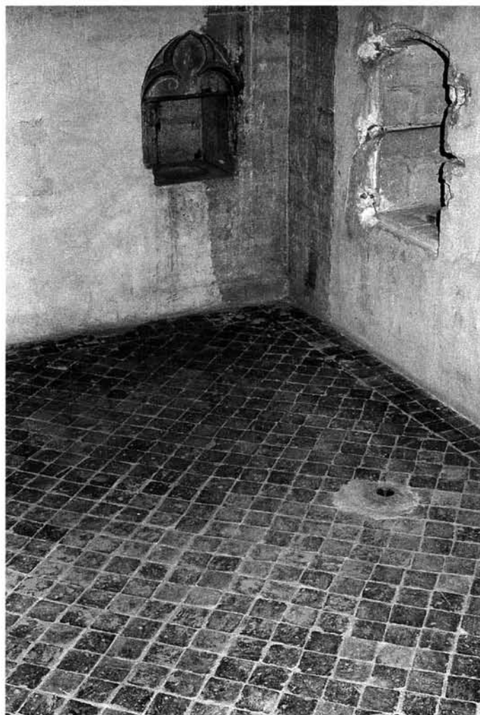
249 - Pavement monochrome de la chapelle.
