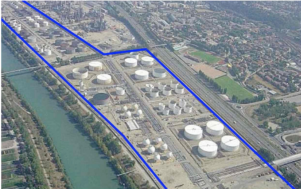
FIG. 2.2 – Le parc des stockages de la raffinerie de Feyzin et le quartier mitoyen des Razes
